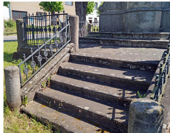
33 - Pohled na kamenné pískovcové schodiště pískovcovými sloupy a kovaným zábradlím před Morovým sloupem - stav 05/2014
