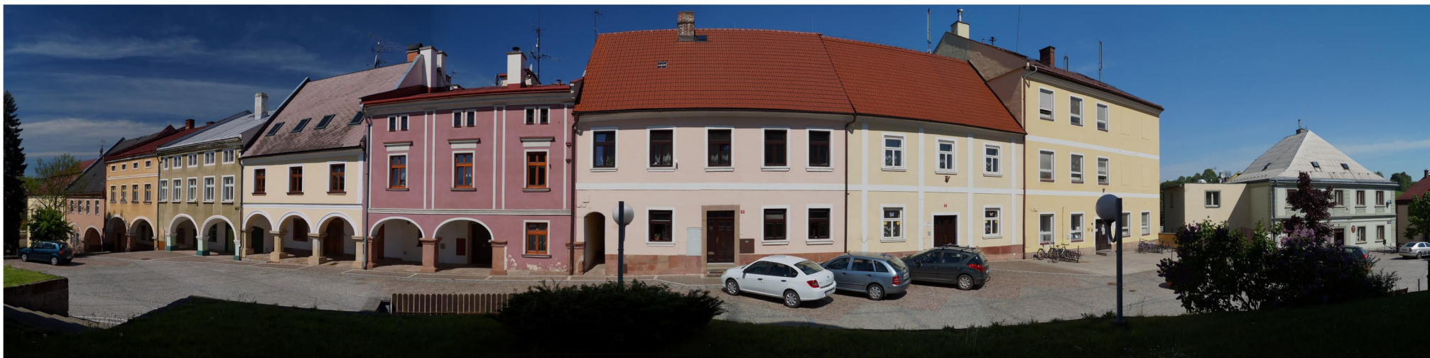
01 - Na panoramatické fotografii je zachycena severozápadní fronta měšťanských klasicistních domů na podloubí č.p. 30, 31 a 32 na Náměstí a dále domů č.p. 33, 34 a 35 bez podloubí. Zcela vpravo je dobře patrný klasicistní dvoupodlažní objekt radnice č.p. 36. - stav 05/2014 Tento hodnotný architektonický soubor je mírně znehodnocen nevhodnými novodobými střešními okny na střeše domu č.p. 31.
