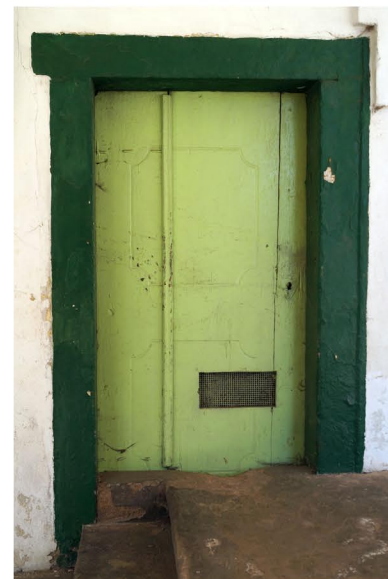
48 - Detailní pohled na barokní svačkové dveře v podloubí domu č.p. 30. - stav 05/2014
