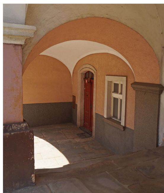
67 - Pohled na nevhodně provedenou rekonstrukci povrchů (syntetická stěrka) v podloubí č.p. 28. - stav 05/2014
