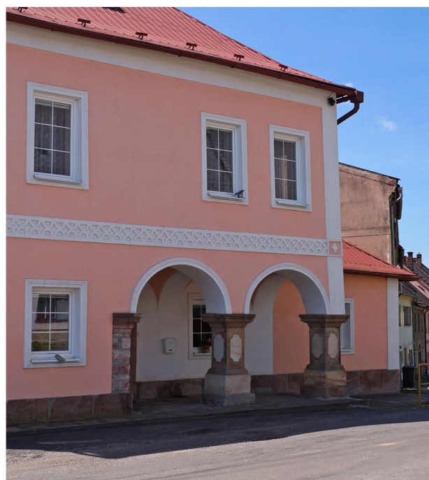
61 - Pohled na objekt č.p. 1, na kterém byl původně provedený reklamní nápis "Malíř písma". - stav 05/2014
