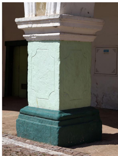
68 - Pohled na sloupek podloubí domu č.p. 30 nevhodně opatřený syntetickým nátěrem. - stav 05/2014
