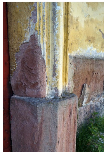
25 - Na fotografii je zachycen detailní pohled na korozí kamene vstupního portálu a soklu severní fasády kostela Nejsvětější Trojice. - stav 05/2014
