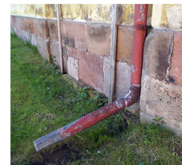
29 - Na fotografii je zachycen pohled na provizorní řešení dešťového svodu na severní fasádě kostela Nejsvětější Trojice. - stav 05/2014
