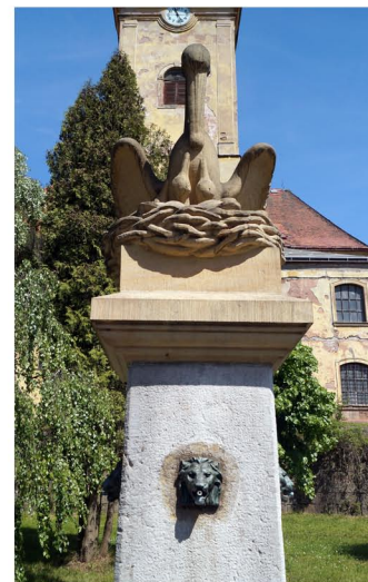
36 - Detailní pohled na plastiku pelikána a chrlíč kamenné pískovcové kašny. - stav 05/2014
