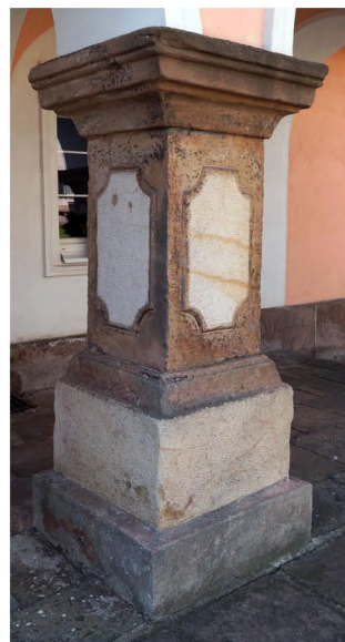
47 - Detailní pohled na sloupek podloubí domu č.p. 1. - stav 05/2014
