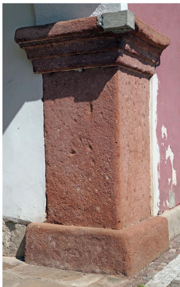
46 - Detailní pohled na sloupek podloubí domu č.p. 32 na pilníkovském Náměstí. - stav 05/2014
