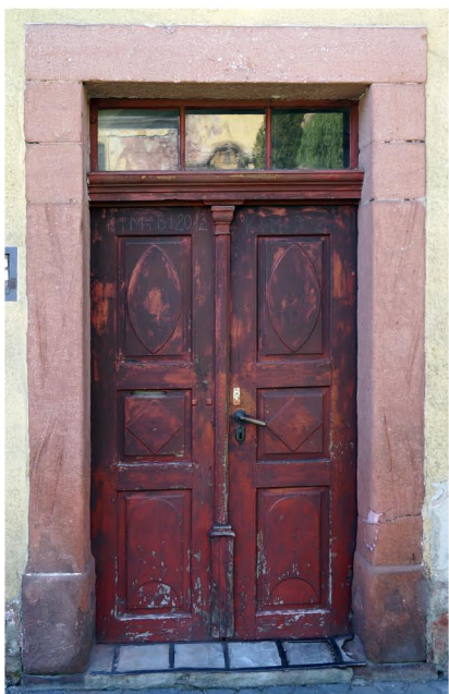
51 - Pohled na klasicistní kazetové dveře s proskleným nadsvětlíkem domu č.p. 9 - stav 05/2014
