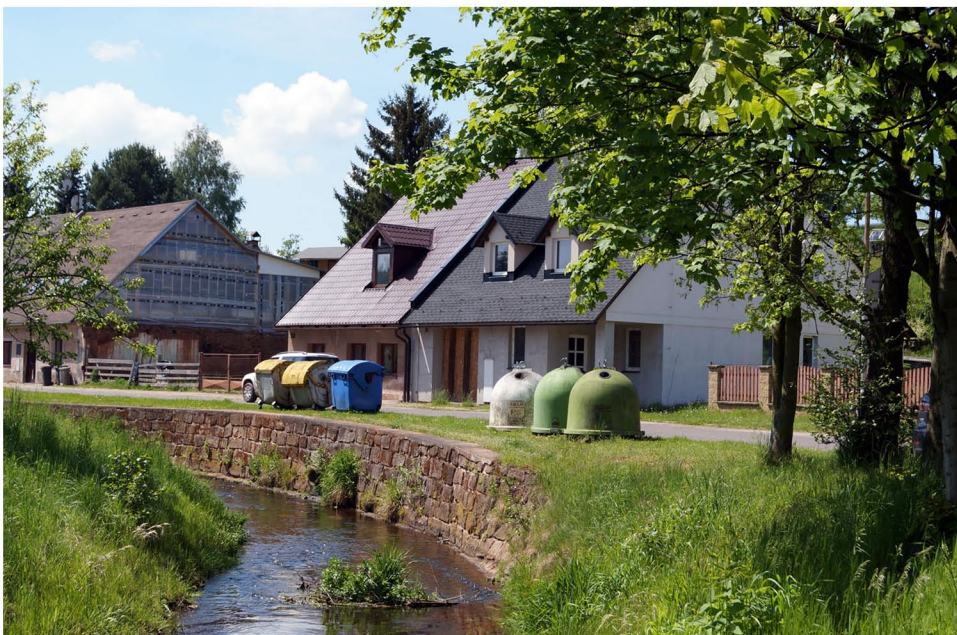
14 - Na fotografii je zachycen pohled na charakteristickou klasicistní jednopodlažní zástavbu v ulici Hradčín, která se nachází těsně za západní hranicí MPZ, která je tvořena korytem potoka. - stav 05/2014
