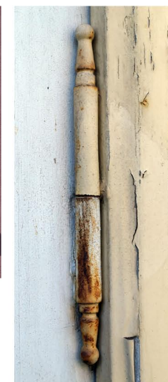
50 - Detailní pohled na tzv. kuželový závěs okna z přelomu 19. a 20. století okna u domu č.p. 10 - stav 05/2014
