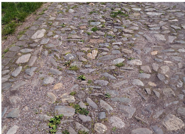
55 - Pohled na historickou zlomkovou dlažbu na erární silnici z let 1816 - 21, dochovaná před č.p. 5. - 7 na Náměstí - stav 05/2014
