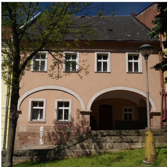
38 - Celkový pohled od východu na dům č.p. 28 na pilníkovském Náměstí - stav 05/2014
