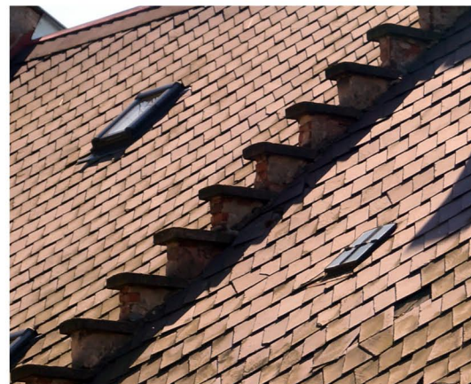
57 - Pohled na břidličnou střešní krytinu, střešní okénko a stupňovitou požární zeď zakončenou pískovcovými deskami u domu č.p. 10. - stav 05/2014
