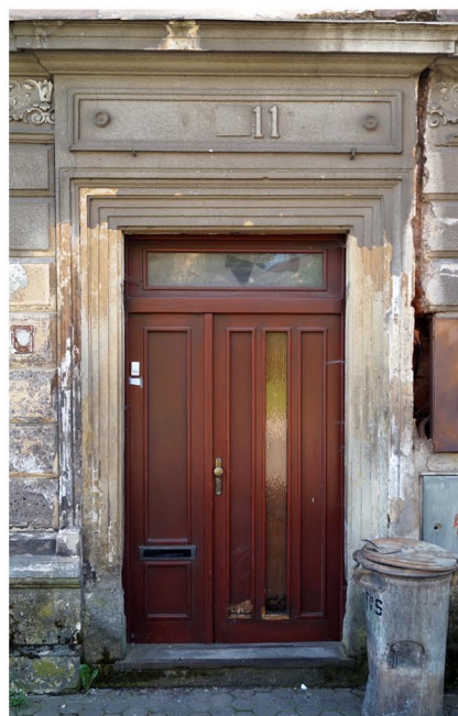
66 - Pohled na novodobé vstupní dveře osazené v původním kamenném portále domu č.p. 11. - stav 05/2014
